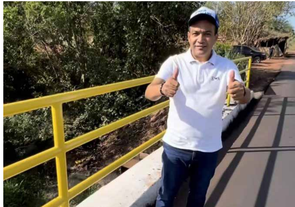
Deputado Júnior Cascaria na Ponte do Quebra Anzol: a restauração foi feita em parceria com o Governo do Maranhão
